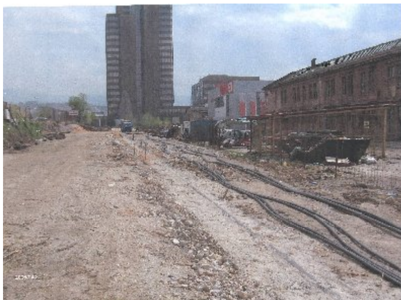
Slika 7.7 Izgradnja dijela sjeverne longitudinalne u Sarajevu uz polaganje kablovskih mreža (Foto: Grcić O., 2006.)
