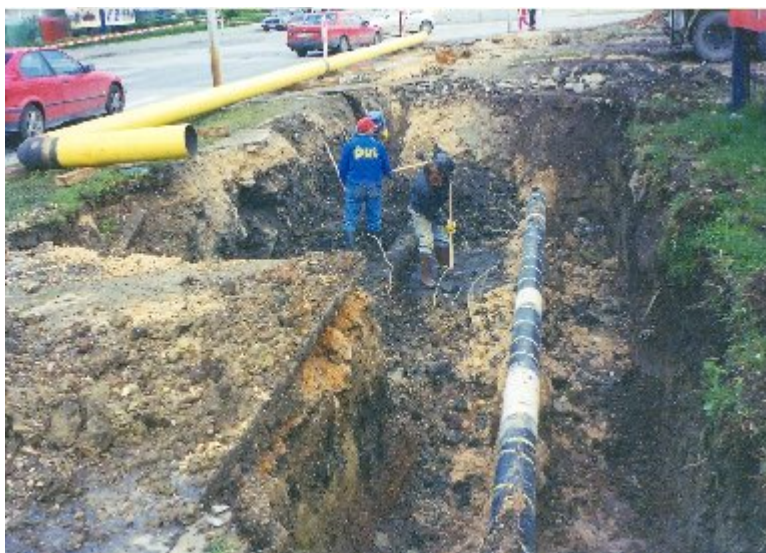
Slika 7.1 Detalj polaganja podzemnih mreža u okviru izgradnje "SJEVERNE LONGITUDINALE" potez od II-ge do III-će transversale u Sarajevu (Foto: Grcić O., 2006.)
